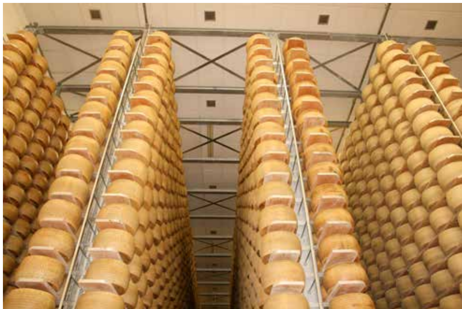
Il sistema di ancoraggio delle nuove scalere alla Latteria del Po di Borgoforte
