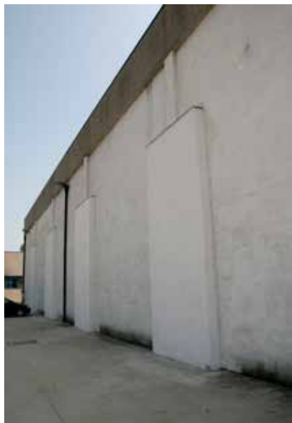
Rinforzi ai pilastri all'esterno del magazzino della Latteria Casaticese di Marcaria
