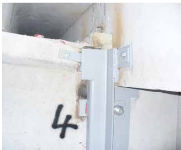
Messa in sicurezza delle travi alla Latteria San Valentino di Marcaria
