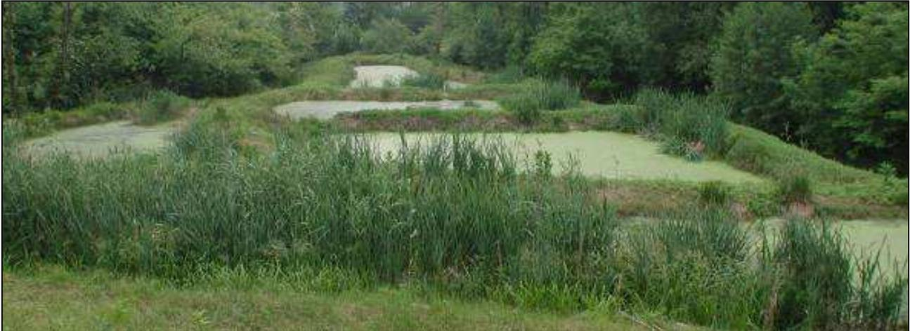
FIGURA 23: SISTEMA DI AFFINAMENTO DELL'IMPIANTO CONVENZIONALE DI CADREZZATE (VA)- FLUSSO SUPERFICIALE (CON E) E SUCCESSIVO LAGUNAGGIO (CON LEMNA MINOR)
