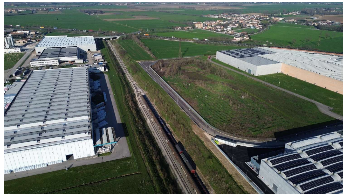
Figura 56. Binario di accesso al Porto di Valdaro.
