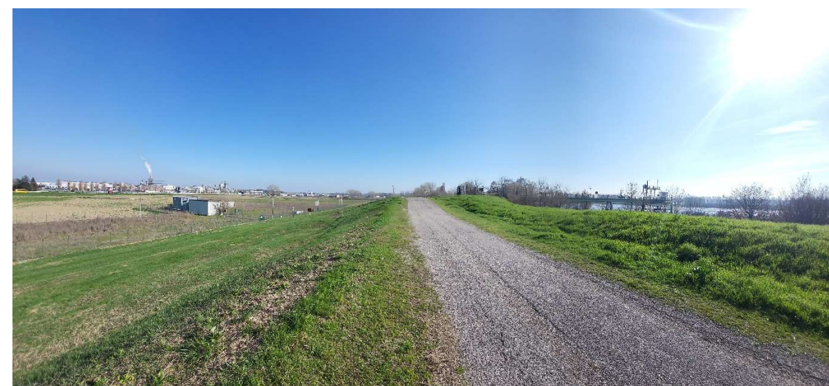
Figura 75. Strada di accesso al pipeline di Viadana (strada arginale sul fiume PO)
