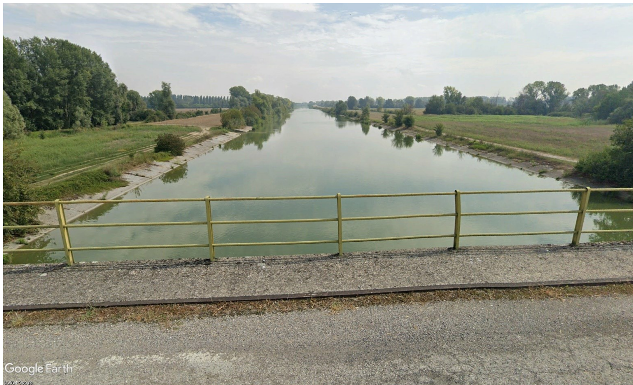
Figura 4.7-2 il Canal Bianco nel tratto a valle dell'area portuale di Valdaro
