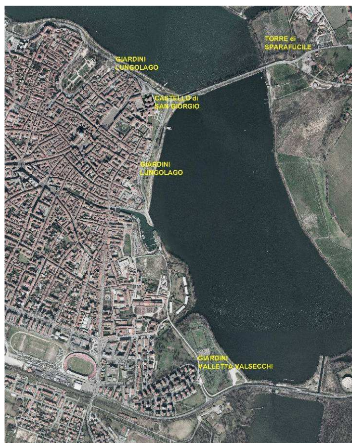
Figura 2: Localizzazione di alcune aree oggetto di deposito di sedimenti dragati
