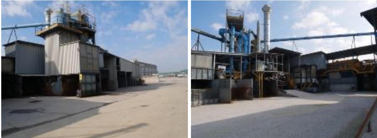
L'impianto per il trattamento dei rifiuti solidi urbani non pericolosi proprietà della Società "La Vetri S.r.l." è costituito da un insieme di macchinari formanti più impianti finalizzati alla lavorazione mediante selezione e valorizzazione di vari materiali, in particolare del vetro, provenienti dalla raccolta dei rifiuti solidi urbani.
