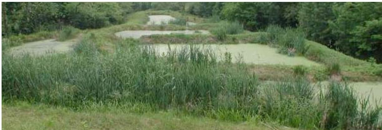
Sistema di affinamento dell'impianto convenzionale di Cadrezzate (VA)- flusso superficiale (con e) e successivo lagunaggio (con *Lemna minor*)
