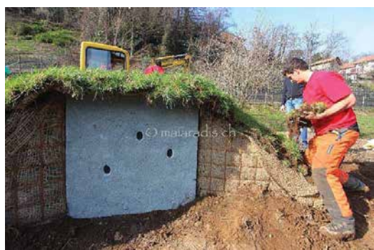
Figura 12. Cassetta nido per Martin pescatore, Topino o Gruccione da installarsi in scarpate di terreno.
