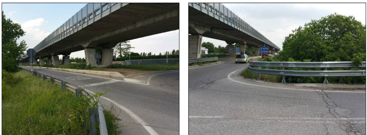
Figura 3-3. Int. 1 – Ingresso da Brescia – uscita in direzione A22
