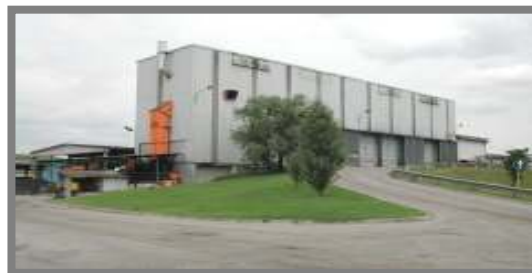
Impianto di trattamento di Pieve di Coriano
