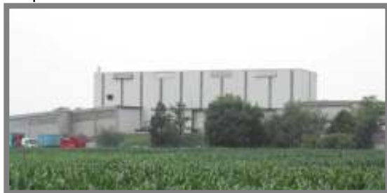
Impianto di trattamento di Ceresara
