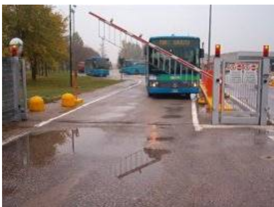
LE SBARRE AUTOMATIZZATE IN DEPOSITO
