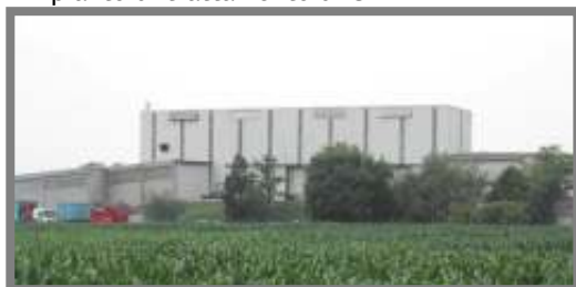
Impianto di trattamento di Ceresara
