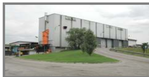
Impianto di trattamento di Pieve di Coriano
