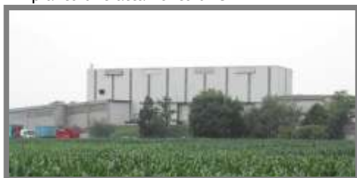
Impianto di trattamento di Ceresara
