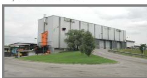
Impianto di trattamento di Pieve di Coriano
