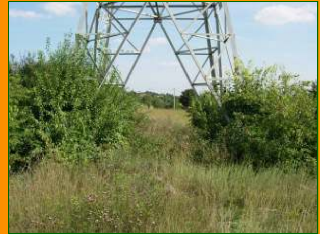
Traliccio dell'alta tensione
